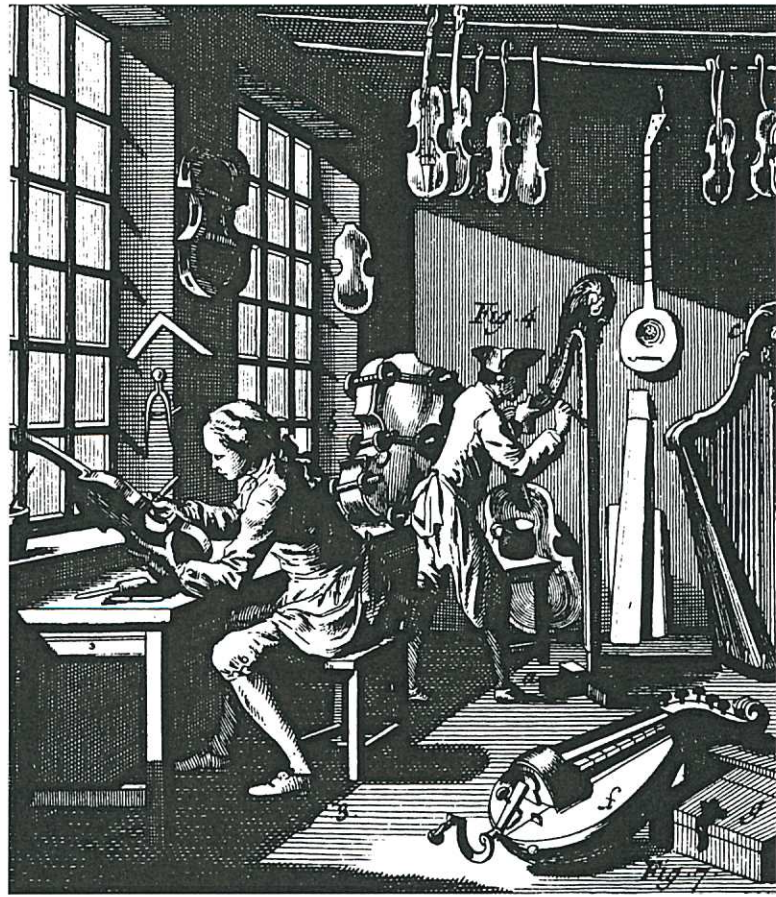
Planche extraite de l'Encyclopédie Diderot et d'Alembert. En voici la légende générale : "La vignette représente l'atelier d'un Luthier, où sont plusieurs compagnons occupés à différens objets de cet Art".
